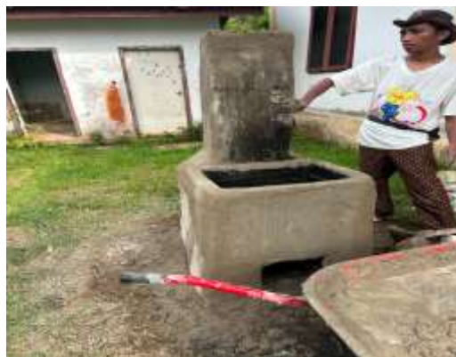
Gambar 6. Kondisi akhir rocket stove yang telah selesai dibangun di Desa Air Jernih
