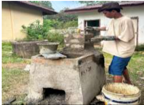
Gambar 5. Proses plesteran permukaan luar rocket stove pada tahap finishing
