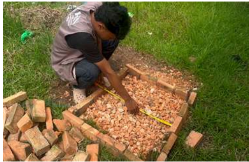
Gambar 2. Lapisan kerikil pada pondasi yang diukur sebelum dicor
