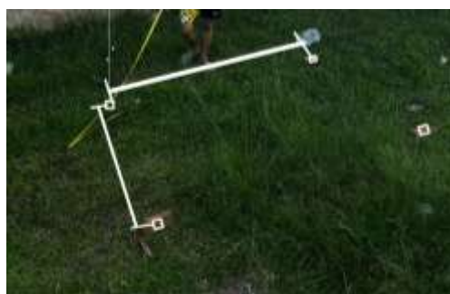
Gambar 1. Pengukuran dan pematokan lokasi pembangunan rocket stove
