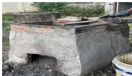
Gambar 4. Penyusunan bata pada bagian heat riser rocket stove
