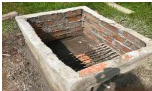
Gambar 3. Struktur ruang bakar dari susun bata dengan tulangan besi sebelum dicor
