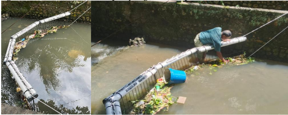
Gambar 5. Pengecekan alat penyaring sampah dan pembersihan sampah
